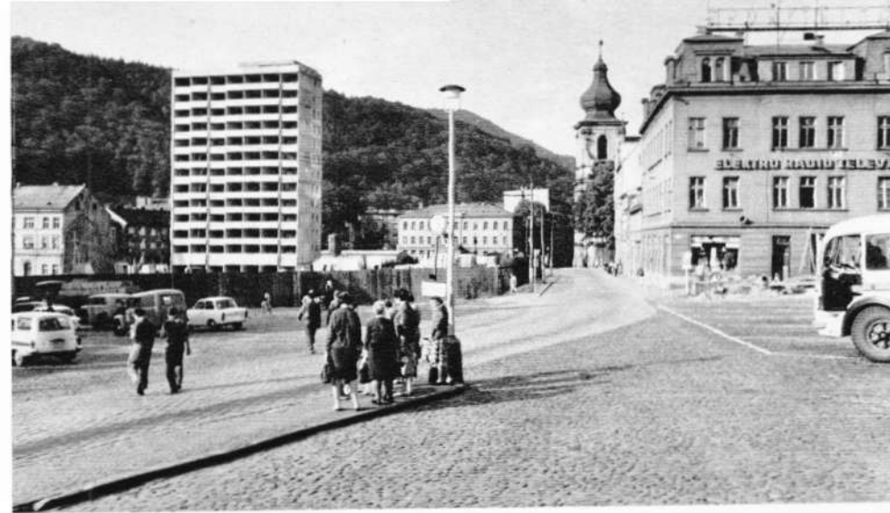
Der entstellte Marktplatz in Tetschen a. d. Elbe. Nach der Sprengung alter Bürgerhäuser entstehen wabenartige Hochbauten. Der geschlossene Stadtplatz wurde bedenkenlos zerstört.
