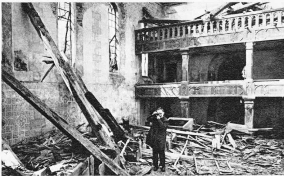
Kirchen und Kapellen verwüstet oder im Verfall Links: Die zum Einsturz gebrachte Pfarrkirche in Güntersdorf im Kreis Tetschen a.d.E. (Aufn. 1968).
