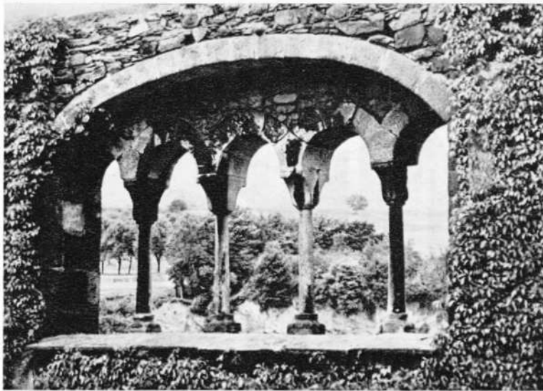
Eine der drei Fensterarkaden vom Obergeschoß des Palas, dessen östlicher Teil von einem großen Saal eingenommen wurde. – Unten: Der sogenannte Mühlurm außerhalb des Burgbezirkes, ein späterer Anbau im Zuge der Stadtbefestigung aus dem Jahre 1467.
