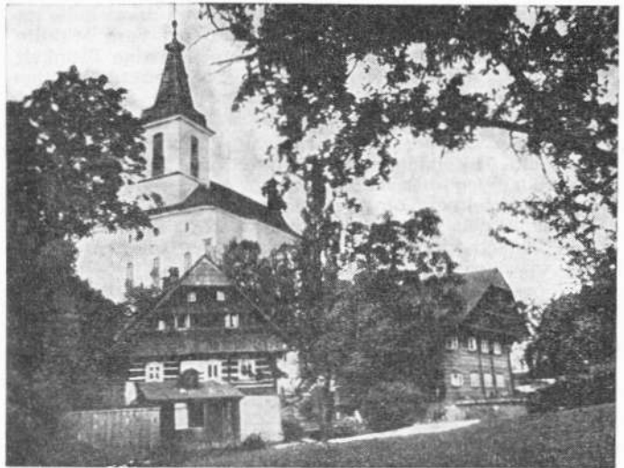
Rochlitz. Den älteren Landsleuten wird dieses Bild Erinnerungen an die beiden schönen alten Holzhäuser, die an der Marktstraße standen, wachrufen. In den Jahren vor dem letzten Weltkrieg wurden sie abgetragen.
