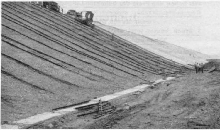
Der Egerstaudamm zwischen Wicklitz und Negrantz (Kreis Saaz). Die Betonabdeckung der Innenseite ist zur Hälfte fertig. Er wurde in jahrelanger Arbeit ganz aus Erdreich aufgeschüttet. Die Dammlänge mißt 3,3 km und hat an der Sohle eine Breite von 800 Meter (Aufnahme 1966).
