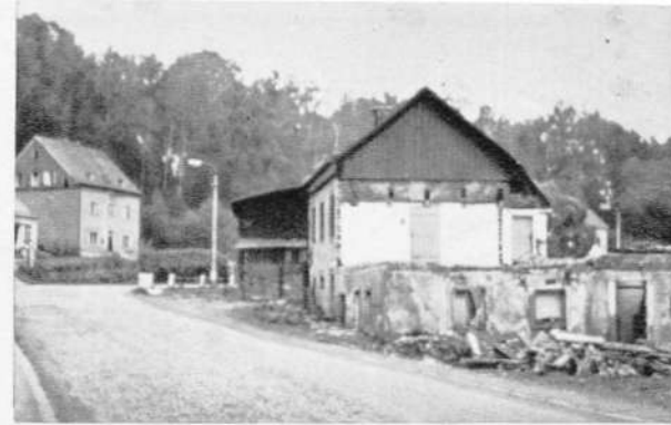
Die ehemals bekannte Eichelmühle in Dallwitz bei Karlsbad, früher ein sehr schöner Fachwerkbau, ist seit drei Jahren eine Ruine.
