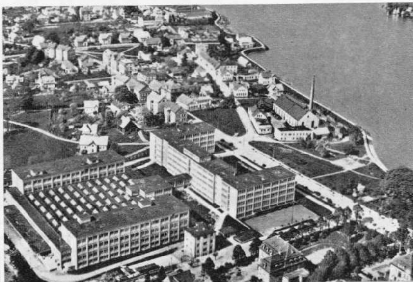
Gablonz heute! Luftbild vom Gelände an der Grünwalder Talsperre. Im Vordergrund das von den Tschechen neuerbaute Ausstellungsgebäude »Jablonec« der staatlichen Bijouterie.
