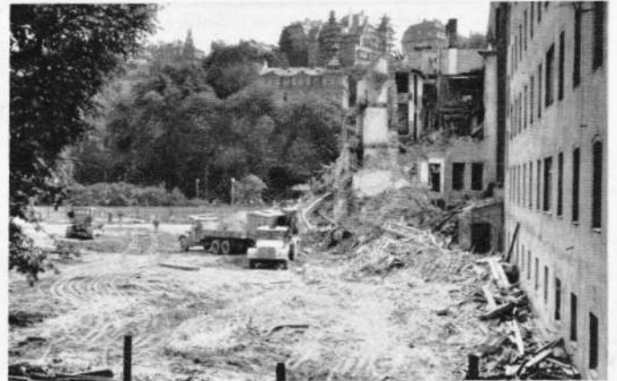
Eine ganze Häuserreihe wird abgerissen, mitten in der Hauptsaison Juli 1966.
