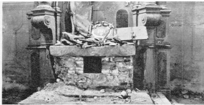
Hier sieht man die mutwillige Zerstörung des Gotteshauses zu Reichen, und man kann es nicht fassen, daß so etwas im 20. Jahrhundert in Mitteleuropa möglich ist. Der zertrümmerte Unterteil des Hauptaltars.
