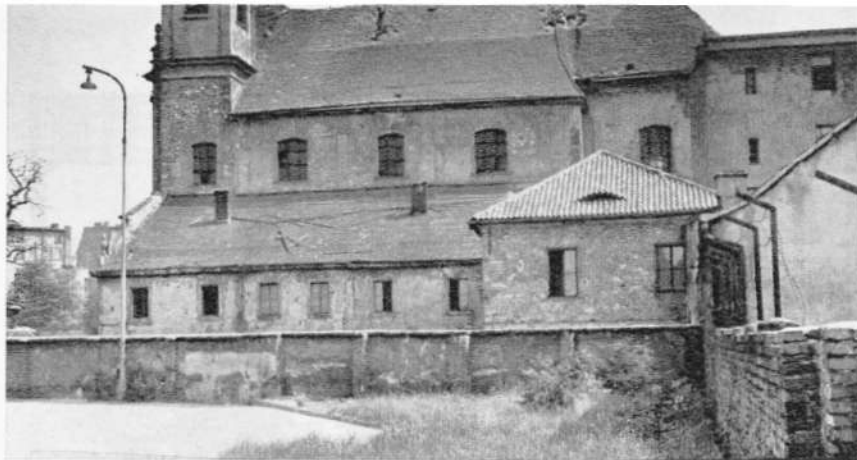
Die alte barocke Klosterkirche in Aussig zeigt große Schäden. Da nichts geschieht, wird die Kirche bald eine Ruine sein.
