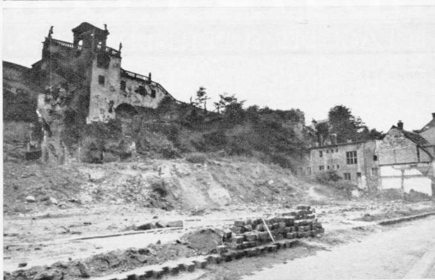
Ein Bild der Verwahrlosung zeigt Tetschen a. d. Elbe. Die Kreuzgasse und die Schloßauffahrt mit der einstmals sehenswerten Gloriette. Im Vordergrund sind die verfallenen Häuser abgerissen worden.
