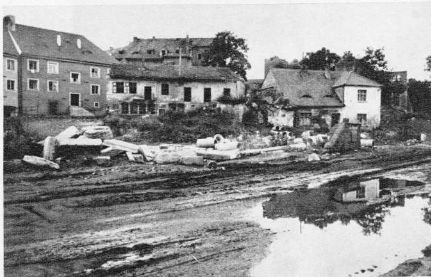
Die Straße zur Wallensteinburg in Eger und die einzelnen Häuser befinden sich in einem desolaten Zustand.
