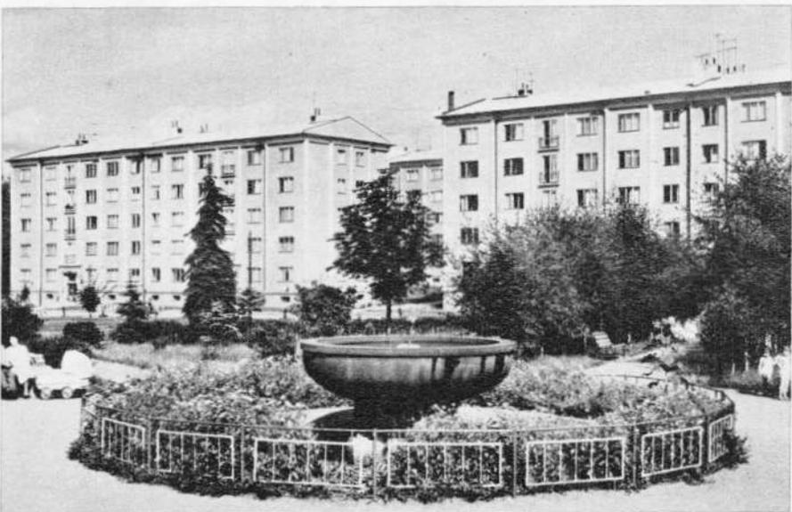
Der Wiederaufbau der stark zerstörten und verwahrlosten Stadt Eger geschieht meist durch Fertighäuser, die durch Zusammenfügen von Betonplatten entstehen. Unser Bild zeigt solche Häuser.
