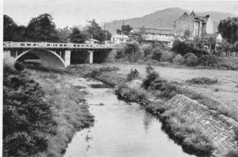
Die neue Brücke von Tetschen-Altstadt.
