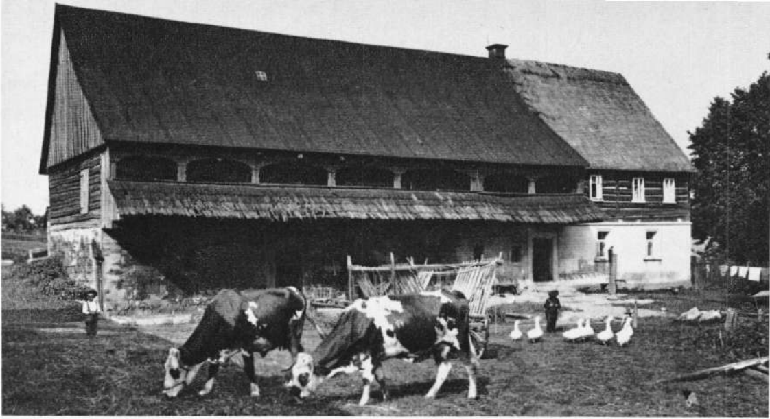
Nordböhmisches Bauernhaus (Wohnstallhaus) mit Oberlauben
