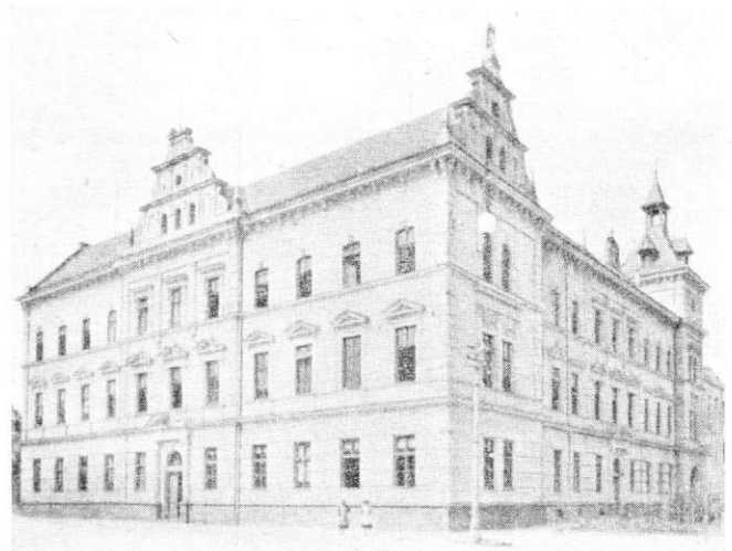
Eine der denkwürdigsten Kulturstätten in unserer Heimat: die Knabenbürgerschule in Hohenelbe, 1876 erbaut und eingeweiht.
