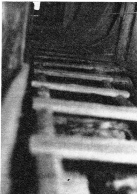
Ein Blick aus dem Schacht, der nur mit hölzernen Leitern zu besteigen ist, an die Oberfläche. „Auf eigene Gefahr“ stieg unser Fotograf in die Tiefe
