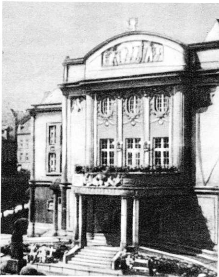
Das Brück Stadttheater, die im ganzen Sudetenland bekannt gewesene Kulturstätte der Kohlenstadt
