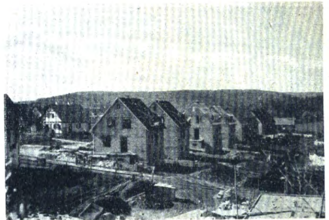
Unter Leitung von Baumeister Gustav Kuhn, Hoheneibe, entstanden heuer diese Neubauten durch eine Selbsthilfe-Baugruppe in Heidenheim.
