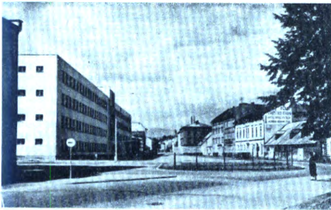
Trautenau, die renovierte Faltisfabrik, in welcher verschiedene Behörden, das Bezirks- und Kreisgericht und große Ausstellungsräume untergebracht sind
