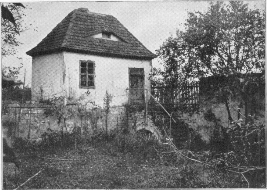
Abb. 11. Gut angelegtes Gartenhäuschen.
