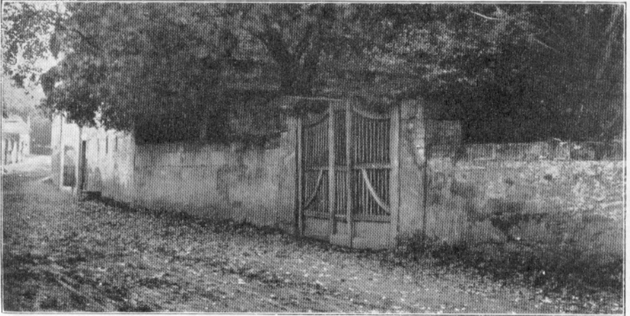
Abb. 4. Gute Gestaltung einer Gartenmauer mit Einfahrtstor.
